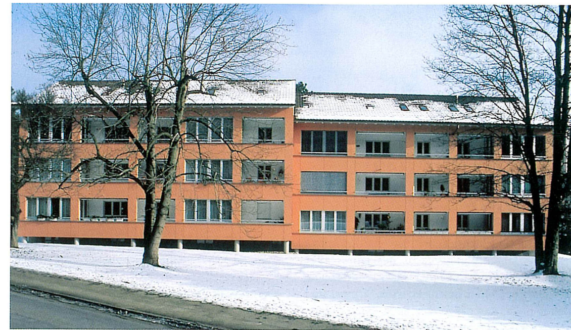
3 | Ansicht von Südwesten (Foto: Thomas Flechtner)
